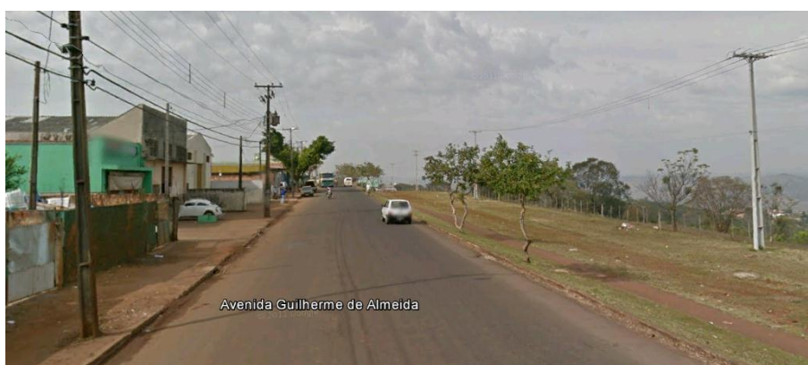
Figura 61: Vista da Avenida Guilherme de Almeida e a falta de sinalização vertical e horizontal.
