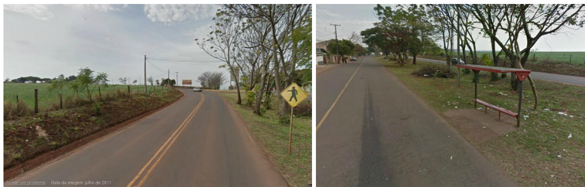
Figura 29: Vista frontal do empreendimento para a Avenida Guilherme de Almeida com a infraestrutura de pavimentação e da Rua dos Cozinheiros, próximo a área do lote proposto, respectivamente.
