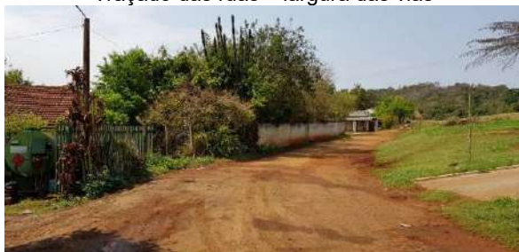
Vias de acesso – sem pavimentação
