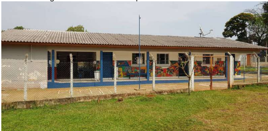
Figura 172 – Escola Municipal do Patrimônio Guairacá
