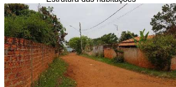
Vias de circulação / cercamanto dos lotes
